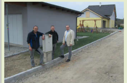
Randleisten an der Siedlungsstraße Albingdorf
