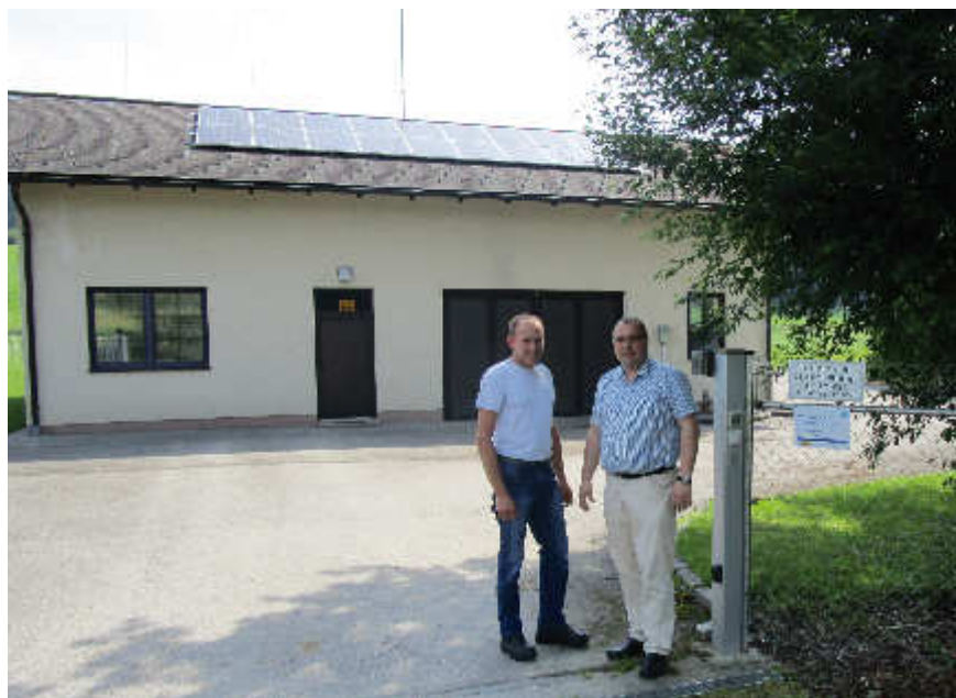
Bgm. Herbert Brandstötter und Johann Katzmayr freuen sich über die neue PV-Anlage auf der Kläranlage
